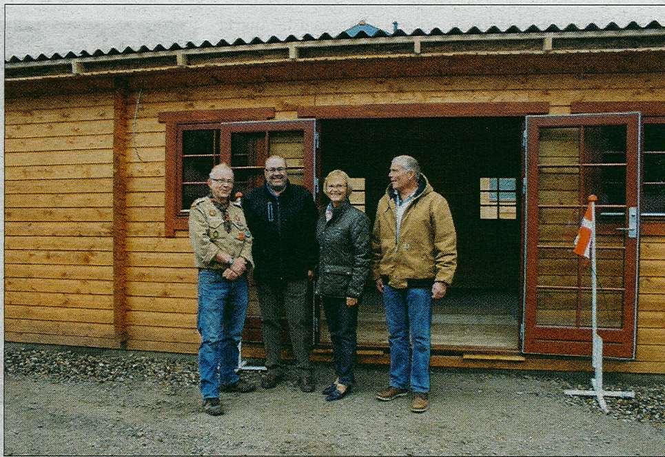
Der blev holdt rejsegilde på den nye spejderhytte lørdag. Fra venstre ses gruppeleder Preben Bjeragger, Jesper Bach og Merete Leisted Busk fra Sorø Spare- og Laanekasses Fond samt tømrer Niels Larsen, der har bygget hytten.
